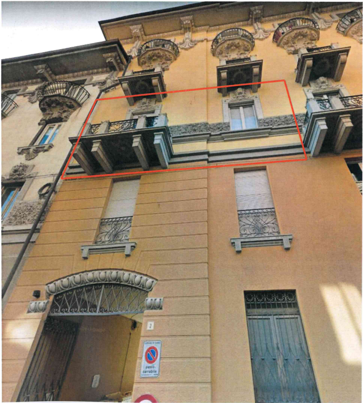
FOTO 1 - Prospetto che si affaccia su Via Statuto
